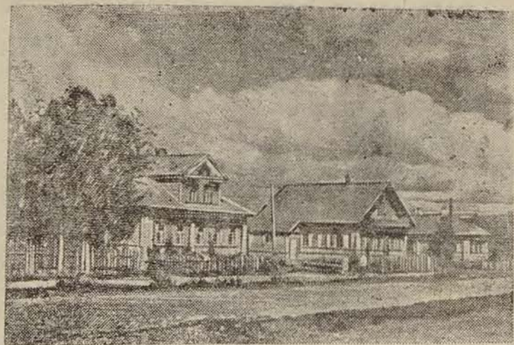
Ярославскэ областым щыщэу Пешехонскэ-Володарскэ районым иколхозэу „Объединенный труд“ зыфилорым колхоз унэхэр щашылх.
